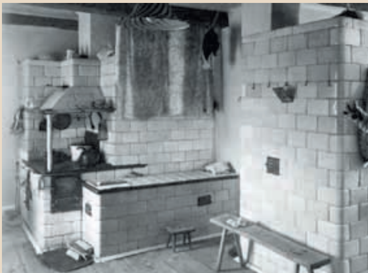
Piec kaflowy o układzie wieloczołowym we wsi Zaleszany w gminie Michałowo.
