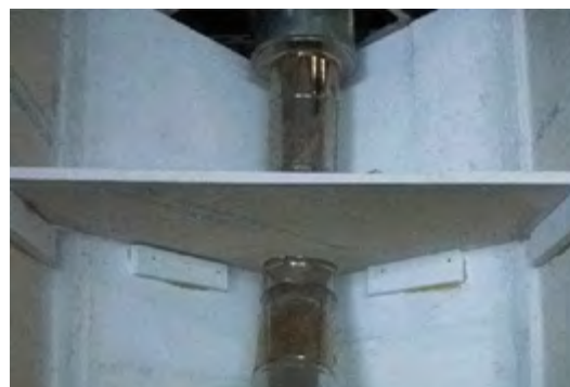
PROMATECT®-L – samonośna konstrukcja obudowy kominka
