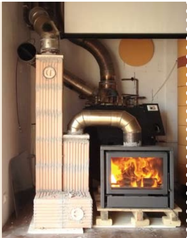
Próba polegająca na sprawdzeniu przydatności zwykłej kasety do akumulacji ciepła
